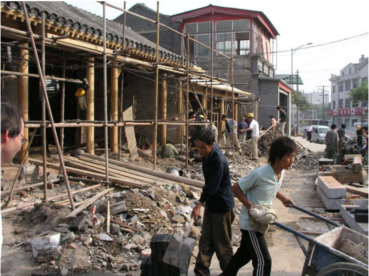
Die alten Stadtviertel von Peking waren noch Baustelle
